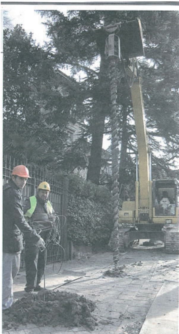
LA TRIVELLA Una fase dei sondaggi nel terreno in viale Cavallotti a Como
